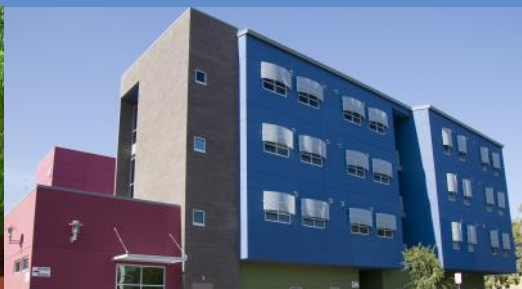
Cambridge House (Phoenix) 18 rooms | Est. 2008
