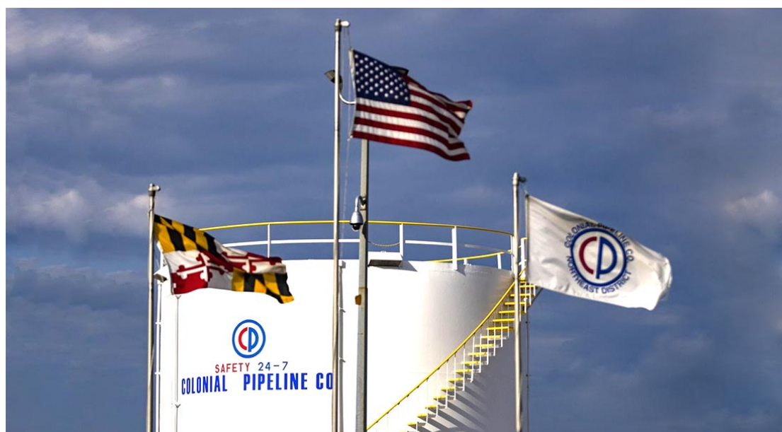
Instalações da Colonial Pipeline (Foto: CryptoID).
